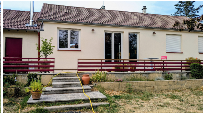
Après les travaux
